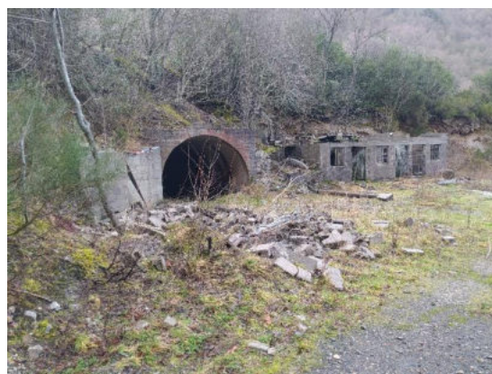
Piso 3, acceso bocamina.
