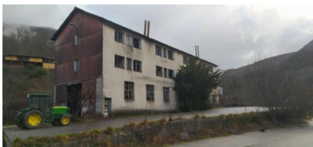
Edificio viviendas Piso 1
