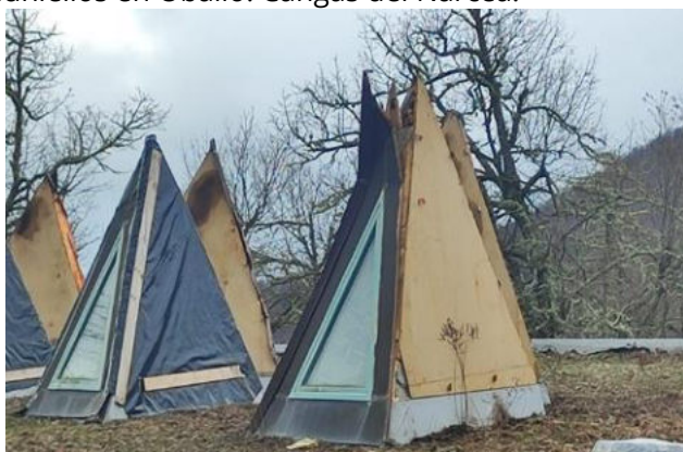
Detalle de los lucernarios sin el recubrimiento de cobre.
